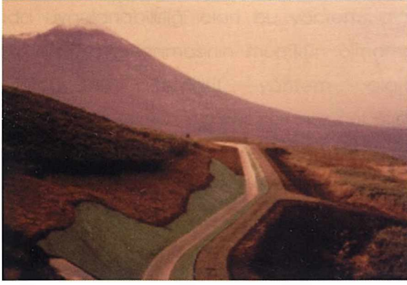
Şekil 10. Maden alanında mevcut yamaçlardan akan yüzey suları kanallar yapılarak ortamdan uzaklaştırılmaktadır.
