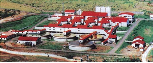
Şekil 2. Matsuo Nötürleştirme Tesisi, Iwate, Japonya.
