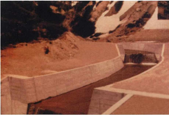
Şekil 11. Madenin bulunduğu yüzeyden geçen küçük akarsu yatakları beton ile kaplanarak, yüzey suyunun yeraltına geçmesi önlenmektedir.
