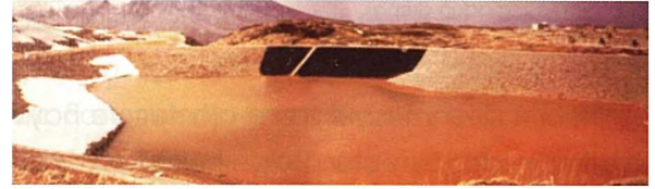
Şekil 9. Nötürleştirme sonucu oluşan sarı renkli sedimentler atık havuzunda biriktirilir.
